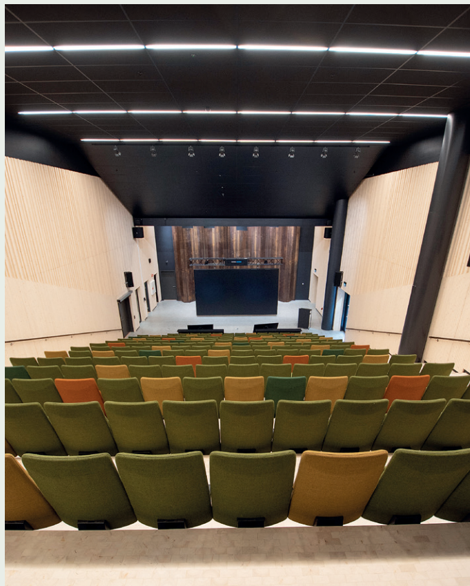
Spunten i prosjektet står igjen permanent nede i parkeringskjelleren, men deler av spuntveggen har også blitt gjenbrukt i andre deler av bygget, som her i auditoriet «Spunten».
